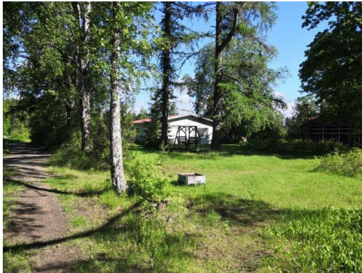
Maatilan talouskeskuksen pihapiiriä tilalla Rauhalahdi, päärakennus 60-luvulta ja edelleen käytössä oleva navetta 50-luvulta
