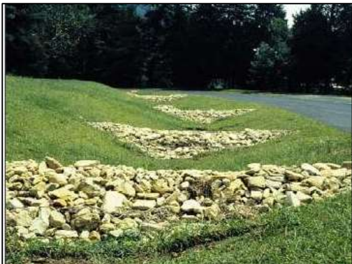
Kuva 6 Esimerkki ojakatkoista (Virginia Stormwater Management Program) ja tyyppileikkaus huoltoteiden yhteyteen rakennettavista viherpainanteista
