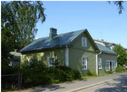
KUVAT: Laakson talon julkisivu (Kuvaaja Nina Uusi-Seppä 2014)
