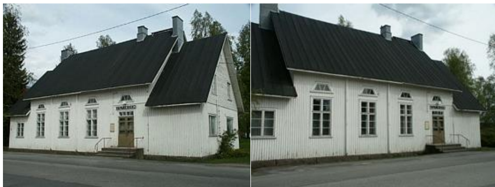
KUVAT: Vapaakirkon julkisivua
