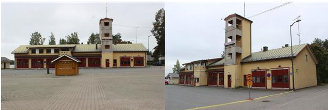
KUVAT: Paloaseman julkisivuja
