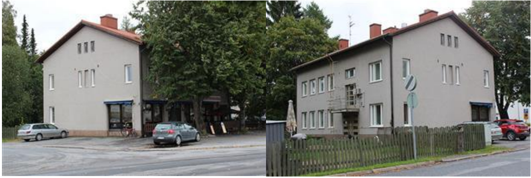
KUVAT: Entisen KOPin rakennuksen julkisivua
