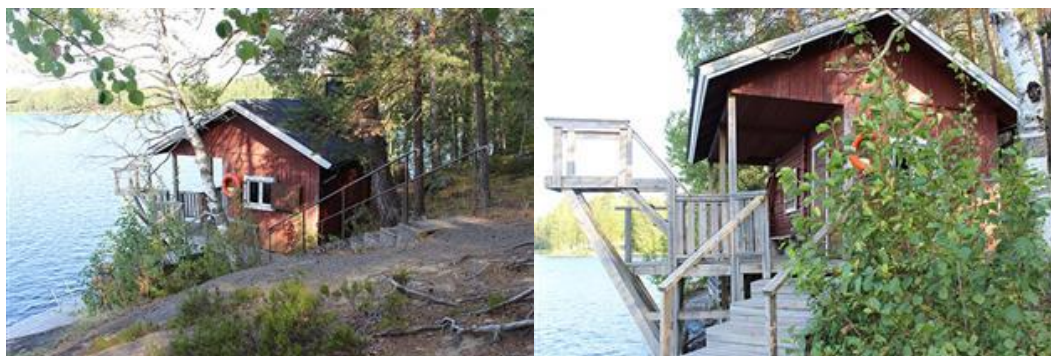
KUVAT: Rantasaunan julkisivuja
