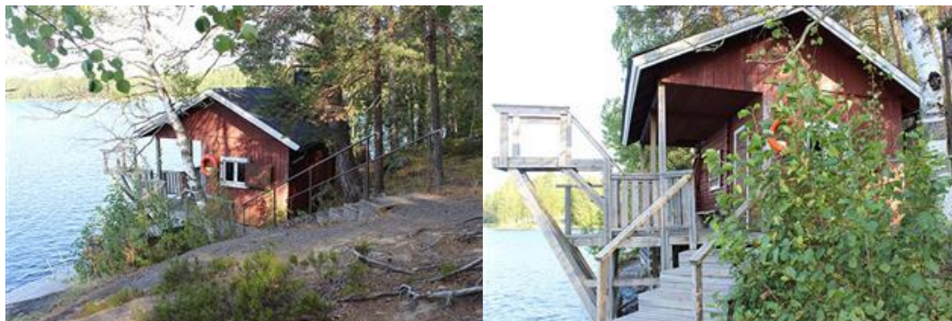
KUVAT: Rantasaunan julkisivuja
