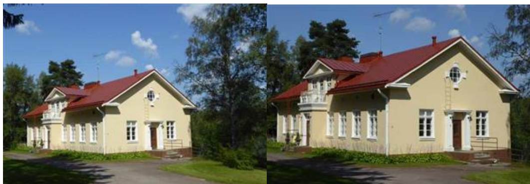
KUVAT: Lääkäritalon julkisivuja (kuvaaja Niina Uusi-Seppä, 2014)
