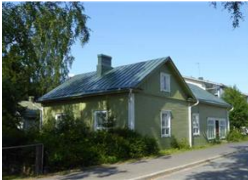
KUVAT: Laakson talon julkisivu (Kuvaaja Nina Uusi-Seppä 2014)
