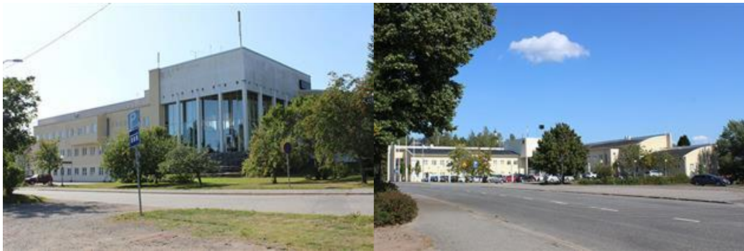
KUVAT: Kangasniemen kunnantalon julkisivuja
