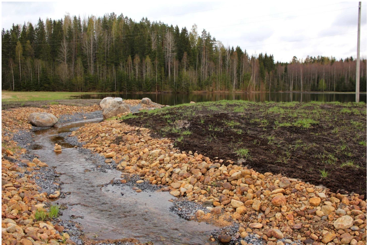
Kuva 1. Esimerkki patopenkereen jatkeeksi rakennetusta pohjakynnyksestä virtausuomineen.
