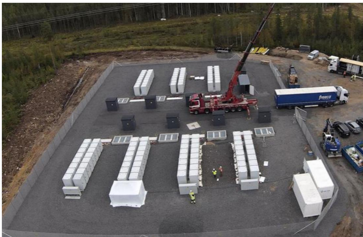
Kuva 8. Kuvituskuva: Akkujärjestelmä rakentuu (Kuva: Kauppalehti)
