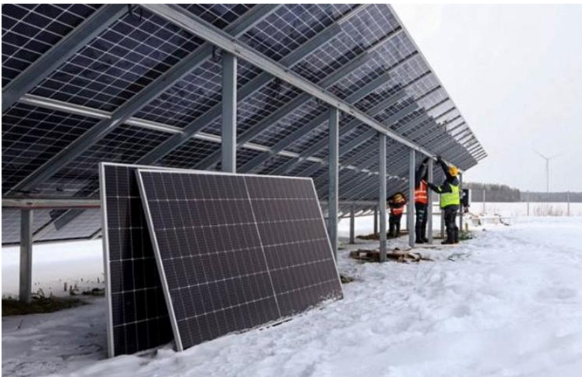
Kuva 7. Paneelit asennetaan 30 asteen kulmaan (kuva Helsingin Sanomat)
