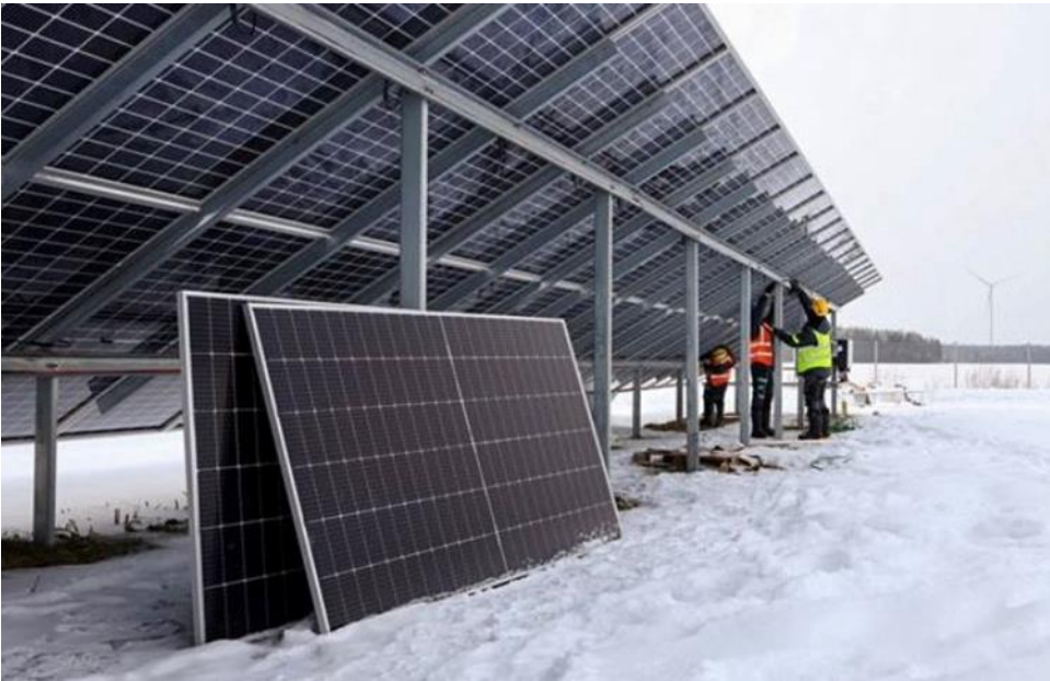
Kuva 7. Paneelit asennetaan 30 asteen kulmaan (kuva Helsingin Sanomat)
