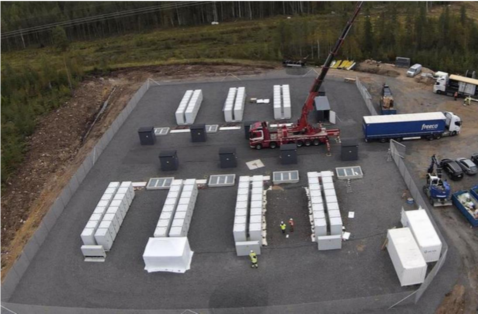
Kuva 8. Kuvituskuva: Akkujärjestelmä rakentuu (Kuva: Kauppalehti)
