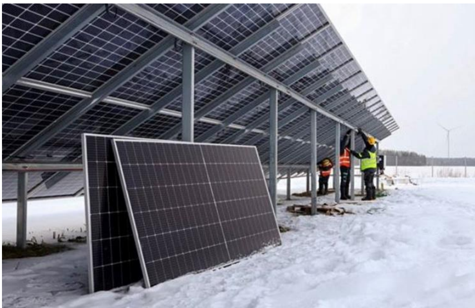
Kuva 7. Paneelit asennetaan 30 asteen kulmaan (kuva Helsingin Sanomat)
